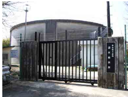
東京都水道局 大蔵給水所
